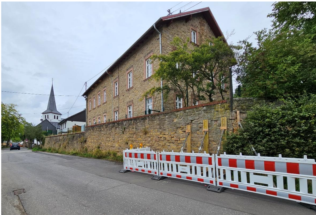
Abbildung 1: Beschädigte Mauer inkl. Abstützung
